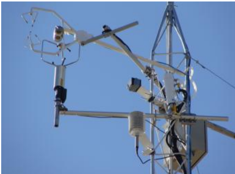
Figura 2: Detalhes da torre na proa do navio.
